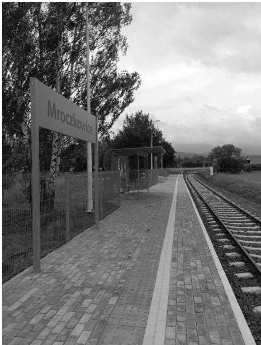
Figura 3-30 - Stația Mroczkowice (Sursa: Google Earth)
